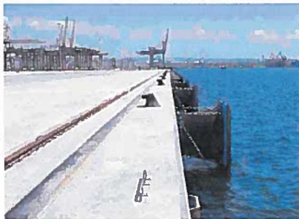
La banchina del molo Polisettoriale appena ristrutturata
